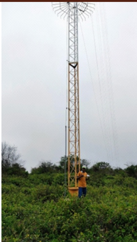
Figura 12: Torres anemométricas de estudo dos ventos (foto: Alzeni Tomáz, 2025)
