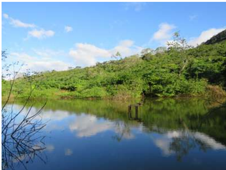
Figura 31: Represa construída pela empresa Leste (BONFIM, 2020).
