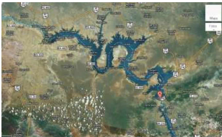
Visão Panorâmica da Barragem de Itaparica. Fonte: Google Maps.
