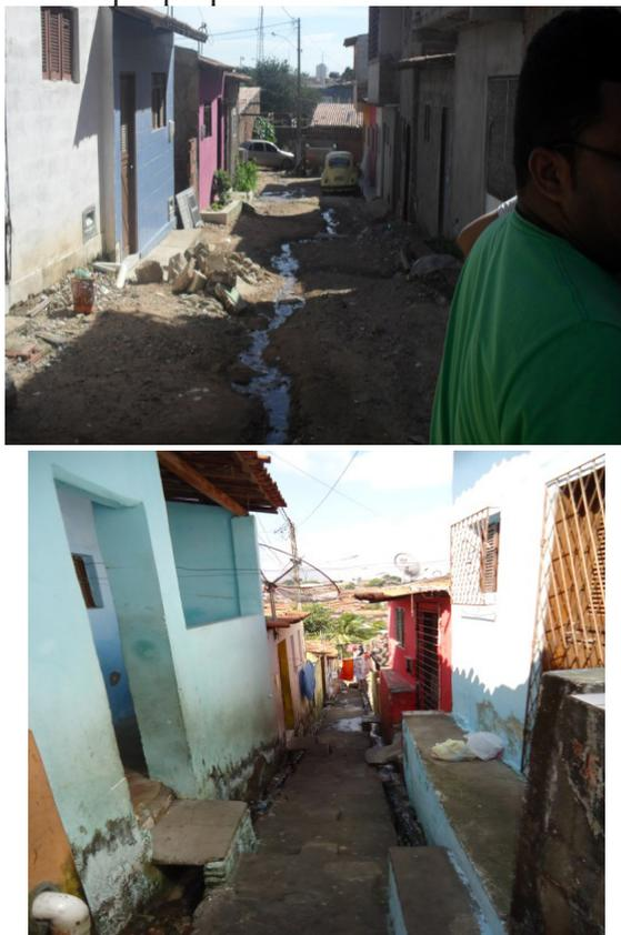
**Figura 07:** Imagens da falta da rede esgoto na cidade de Natal/ RN. Esquerda: Casas na comunidade 13 de Maio (bairro Dix-Sept Rosado) que lançam efluentes de águas servidas diretamente na rua causando erosão laminar. Direita: Viela na comunidade do Japão, bairro das Quintas, apresentando alta declividade e impermeabilização, favorecendo ao *runoff*. Fonte: MEDEIROS, 2014.
