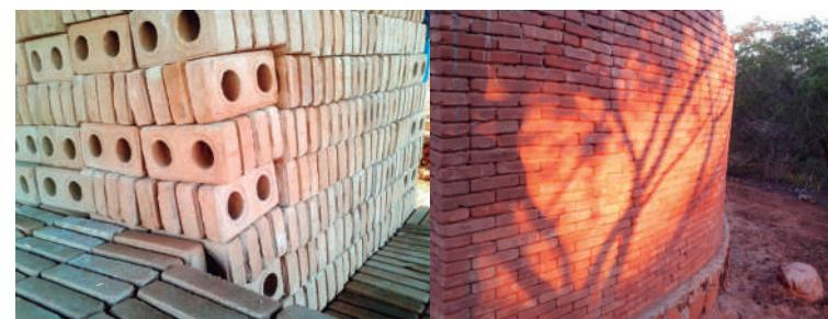
Figura 2 e 3: Tijolo ecológico (à esquerda em espécies e à direita na construção) (Wataru, 2013).
