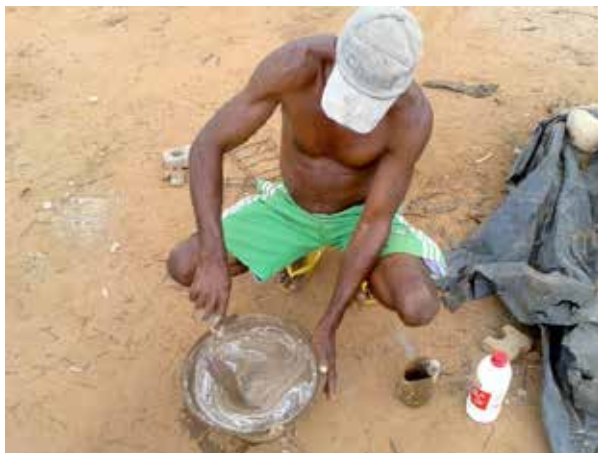
Figura 3: Utilização de mangueira e água para nivelamento; cola e barro para assentamento (Wataru, 2013)
